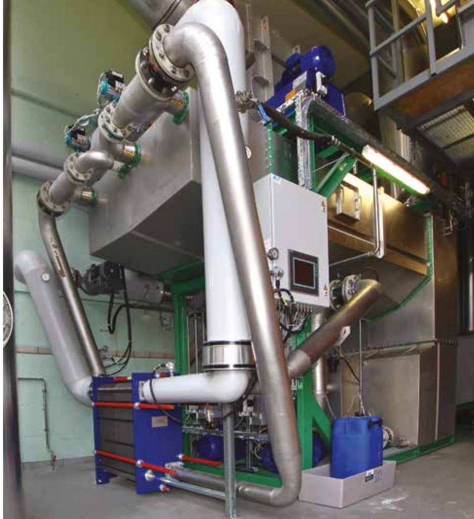
Condensador integrado en una caldera de biomasa
