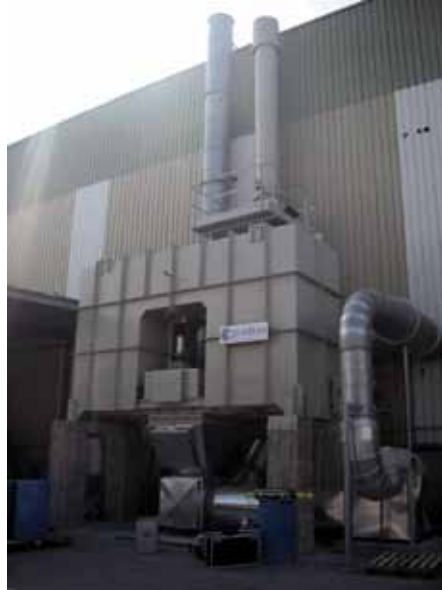
Oxidación térmica regenerativa 2 Torres
