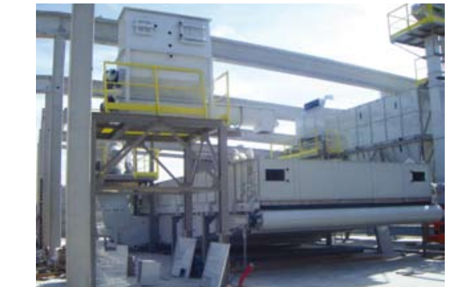
Montaje del sistema de secado de banda
