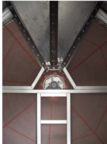
Vista del interior del roto-concentrador
